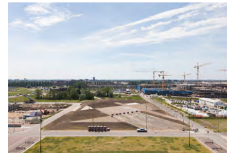
Het Berlijnplein in 2017, aan het begin van de bouw credit: Juri Hiesch
